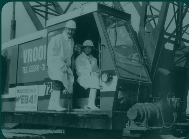
Leo en Luke van Adrichem slaan in 1998 de eerste paal voor het huidige pand aan de Zwethove.
